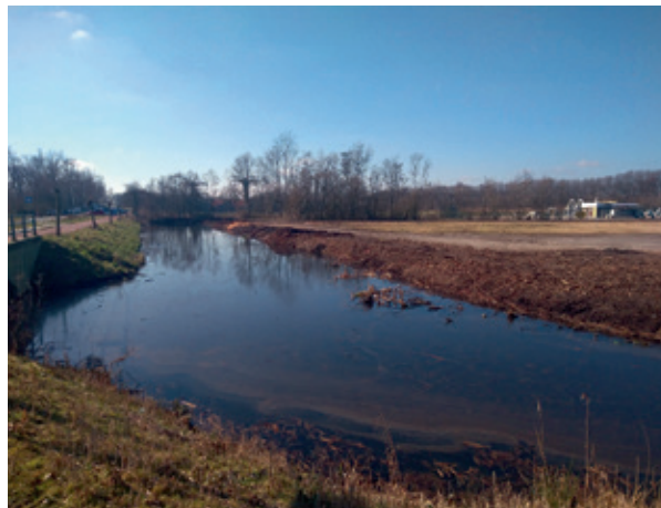
2025 Molenwetering en kaal gemaakt terrein voor het nieuwe Transformator- en schakelstation.
