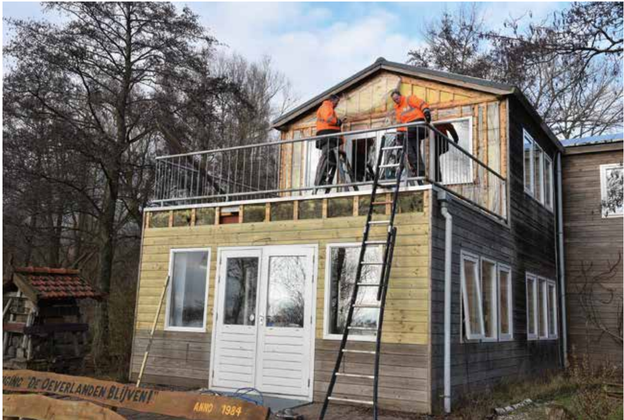
Renovatie gevel 'de Waterkant' / Foto: Tom Koudstaal
