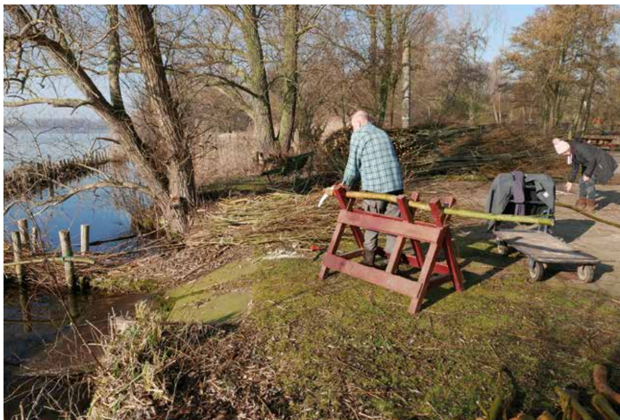
Werkzaamheden op het depot voor oeverbeschoeiing / Foto: Hans Bootsma
