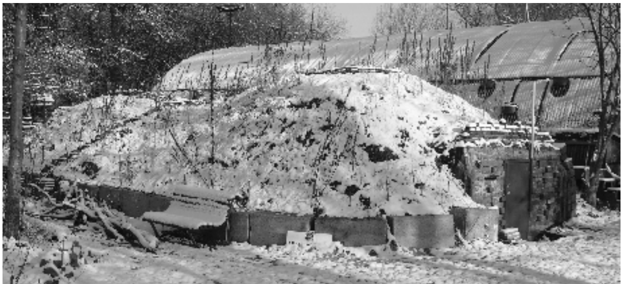
De vleermuisbunker in wintertooi. Het geheel is 18 meter lang waarvan een kleine 15 meter voor de vleermuizen bestemd is. De eigenlijke tunnel is een kleine 3 meter breed bij ruim 1,60 hoog. Links van de toegangsdeur is de brievenbusachtige opening te zien. foto: Hans Bootsma
